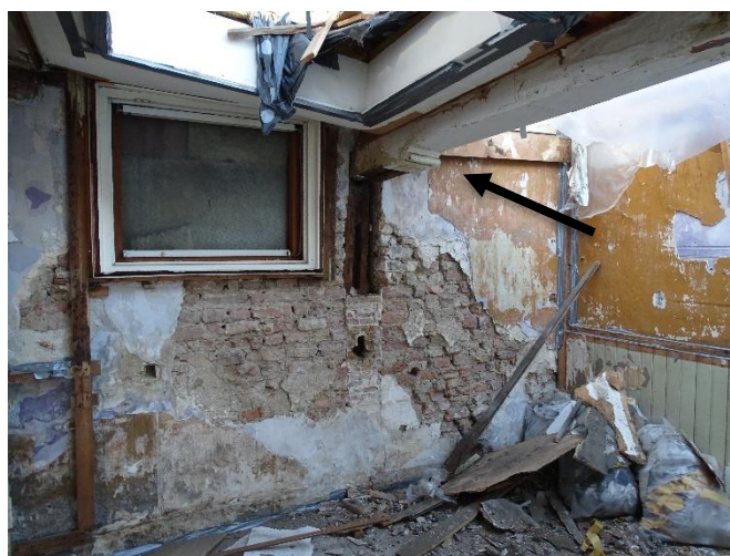
Centrale draagbalk voorzien van een peerkraal-versiering. Ook te zien zijn restanten van een houten staander. Het restant van het korbeel is hier al verwijderd.
